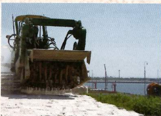
▲スタビライザによる施工状況(粉体添加)
