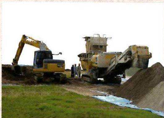
▲自走式土質改良機による施工状況(粉体添加)
