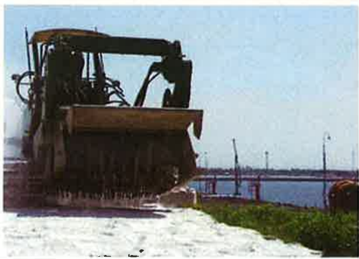
▲スタビライザによる施工状況(粉体添加)
