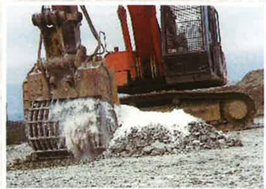
▲バケットスタビライザによる施工状況(粉体添加)
