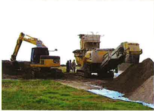
▲自走式土質改良機による施工状況(粉体添加)
