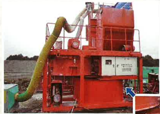
▲スラリーによる施工状況 ※スラリー作製状況
