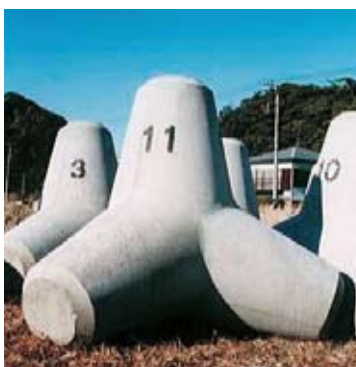
海岸設備（消波ブロック）
