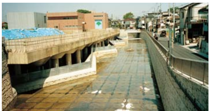
白子川比呂橋下流調整池
