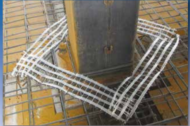
スラブ柱周りひび割れ補強
