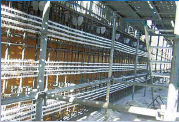
L型擁壁のひび割れ抑制
