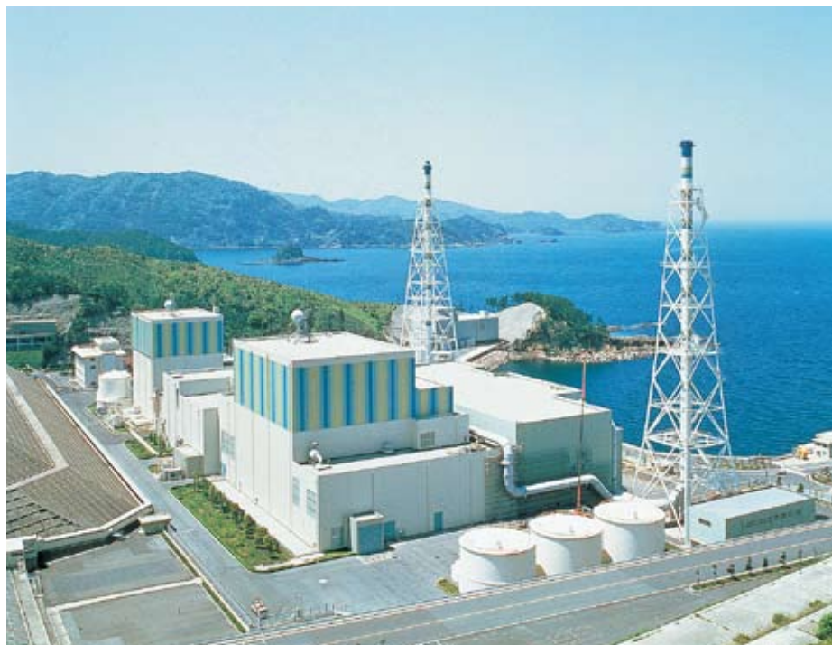
島根原子力発電所
