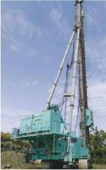
クローラ型三点支持式杭打機
