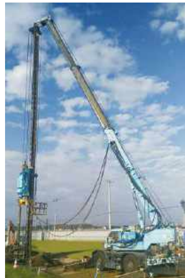
ラフター型杭打機
