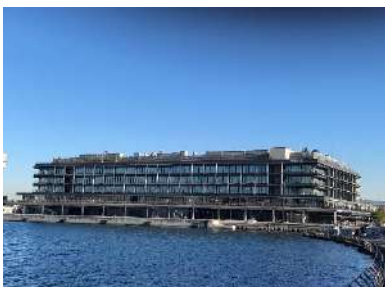
新港ふ頭客船ターミナル
