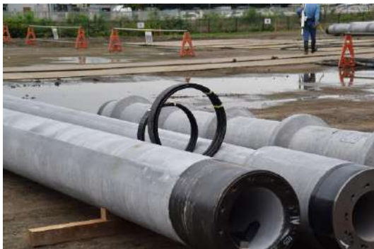
既製コンクリート杭
